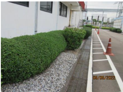
ภาพที่ 2.1-5 รางระบายน้ำฝนภายในโครงการ
